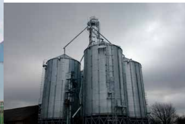
Silosy lejowe obiektu w niemieckim Groß Babelin przeznaczone do magazynowania ziarna w postaci suchej i mokrej wykonane są z blachy falistej.
