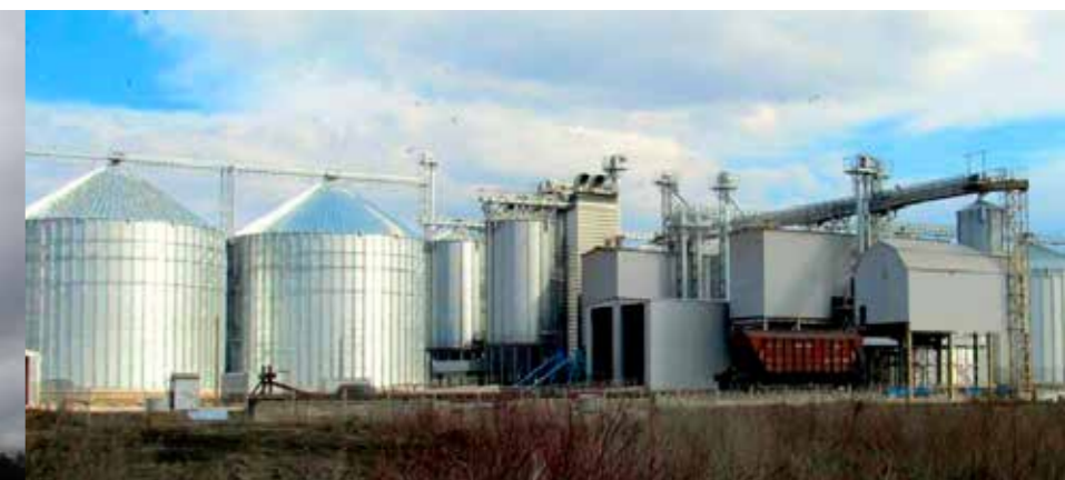
Fundamentem imponującej bazy magazynowej w Teofipolu na Ukrainie są 2 silosy płaskodenne o pojemności blisko 16,8 tys. t każdy - największe zbudowane dotychczas przez Feerum.
