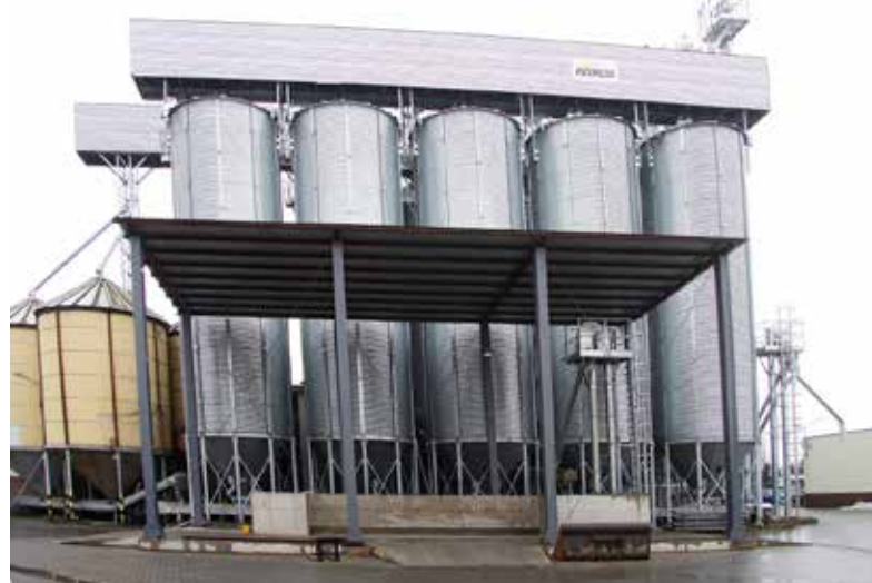
W obiekcie nasiennym w Kluczborku zastosowano m.in. taśmy zamiast redlerów.
