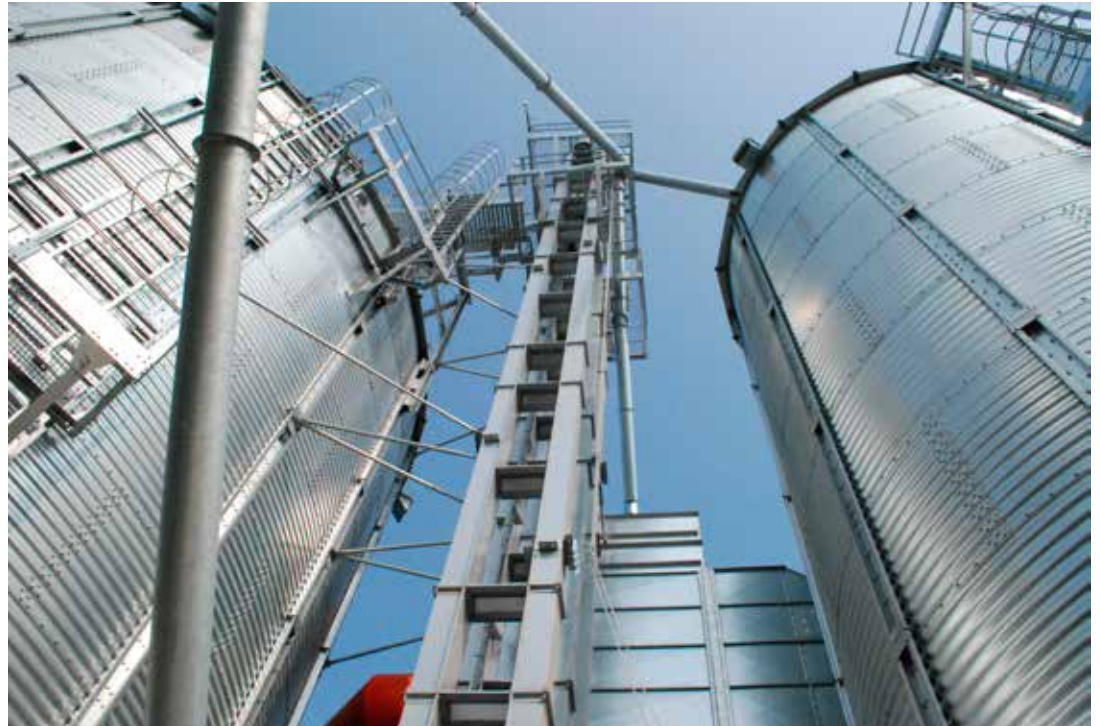
Obiekt magazynowo-suszarniczy w gospodarstwie Stanisława Krawca w Gierałcicach składa się przede wszystkim z suszarni o wydajności dobowej 120 t (kukurydza), 3 silosów płaskodennych mieszczących łącznie 2,5 tys. ton ziarna, silosu buforowego (160 t) oraz urządzeń transportujących.
